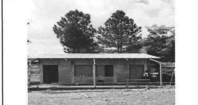
Foto 2: Instalación de lamina troquelada de corredor
