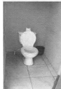
Foto 2: Instalación de segundo baño.
