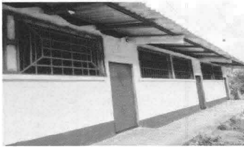
colocacion de pintura en la en los segundos balcones y puert
