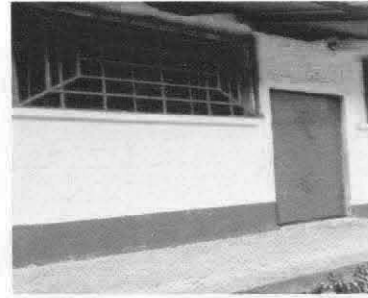
Foto 2: Pintura colocada en primera puerta.
