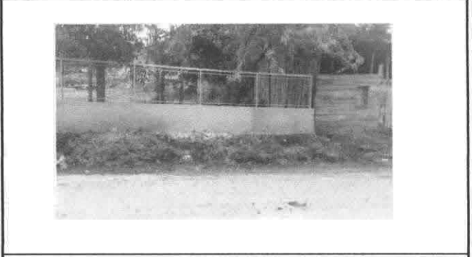
Foto 2: Parte frontal de muro lado derecho.
