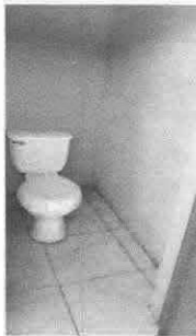
Instalación del tercer baño.
