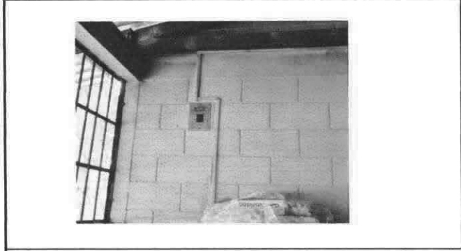
Foto2: Cambio de tablero de flipon.
