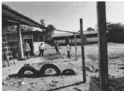
Foto 3: Sacando poste de la galera.
