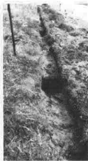
Foto 3: Zanqueo par realización del muro.
