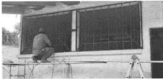
Foto1: Raspado de balcones.
