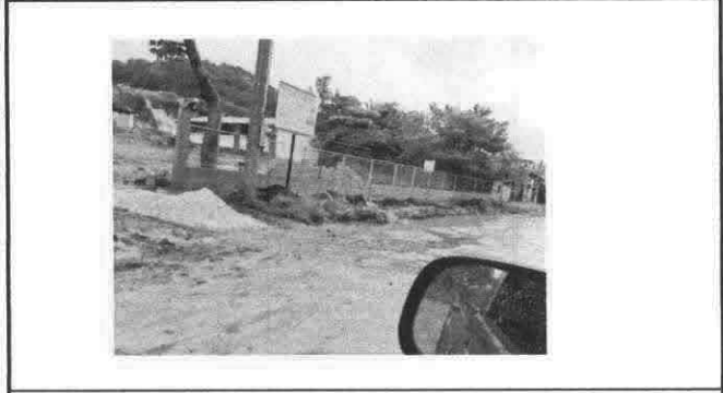
Foto1: Terminación de muro.
