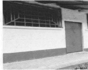
Foto 2: Pintura colocada en primera puerta.
