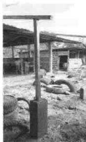
Foto 5: Instalando costaneras de metal.
