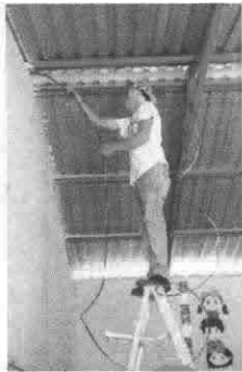
Foto 3: Instalación de acometida eléctrico.
