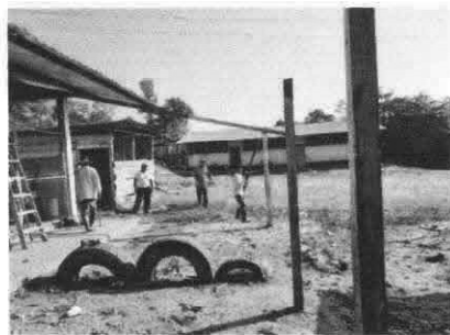
Foto 2: Quitando vigas de la galera.
