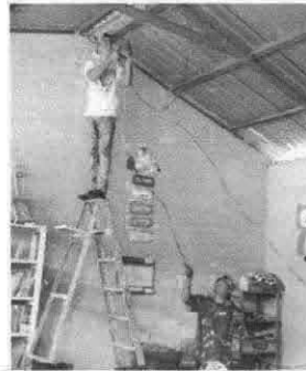
Foto 4: Instalación de cableado en aulas.
