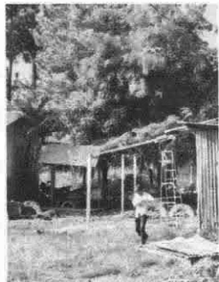
Foto1: Desarmado de galera.
