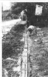
Foto 5: Levantado de muro con block.
