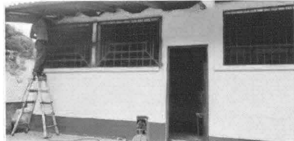
Foto 2: Pintado de balcones.
