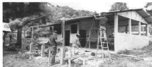
Foto 6: Siguen con la costanera de metal su colocación.
