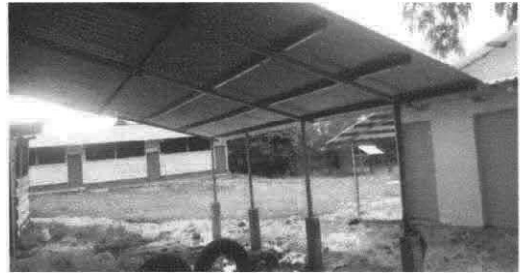
Foto 2: fundiciones de concreto para más durabilidad.
