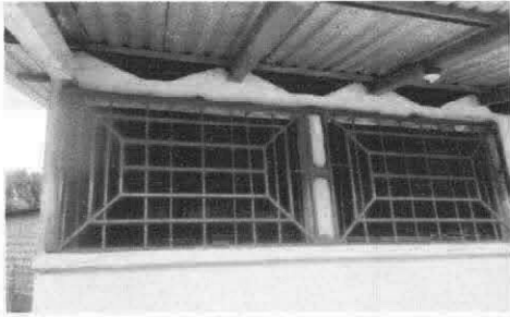
Foto1: Pintura colocada en los 2 orimeros balcones.
