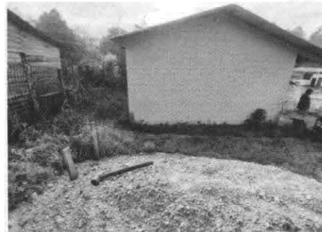
Foto 4: Mejoras para el establecimiento con sevicio sanitario.
