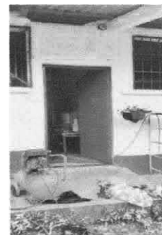
Foto 4: Primera puerta terminada.
