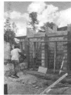
Foto 4: Fundición para que hagan forma las divisiones.
