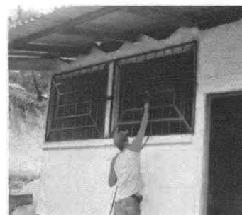
Foto 6: Pintura de los ultimos balcones.
