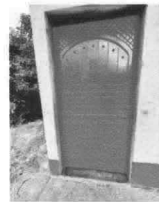
Foto 4: puerta terminas de ultima aula.
