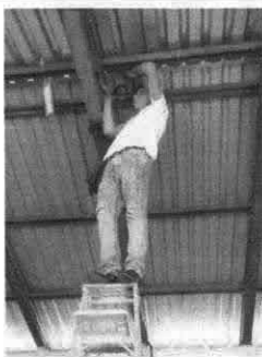
Foto 5: Instalación de bombillos ahorradores
