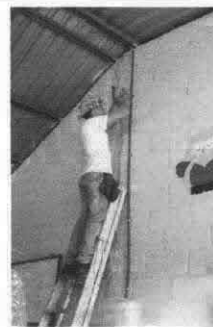
Foto 6: Instalación de tomacorrientes.
