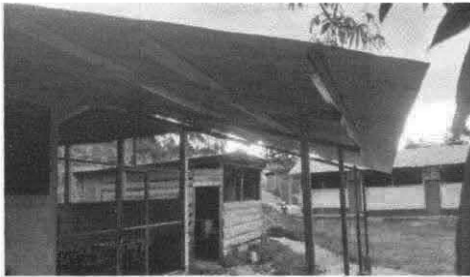
Foto1: Ya esta instalada la nueva lamina de la galera.
