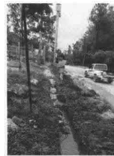
Foto 4: Colocación de piedras para fundición.
