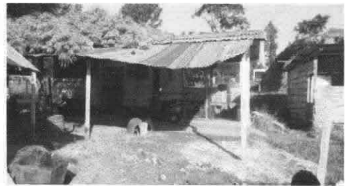
Foto 4: vista de galera con laminas viejas.
