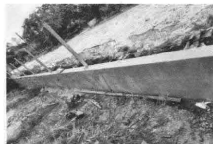
Foto 6: Colocación de mtuberia para malla.
