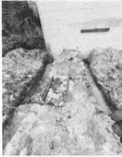
Foto 1: Zanjeo para realización de los baños
