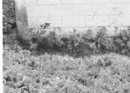
Foto 2: lugar donde se hara el zanjeo.
