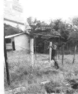
Foto 2: Retiro de postes de cerco.
