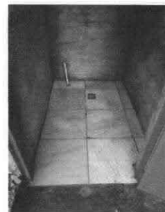
Foto 6: Instalación de piso cerámico.
