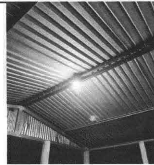
Instalación de cableado y luz en comedor.
