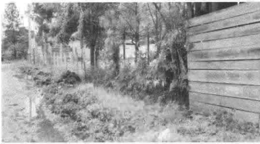
Foto 3: Reparación de malla
