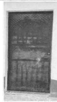
Foto 2: balcones sin pintura y oxidados.
