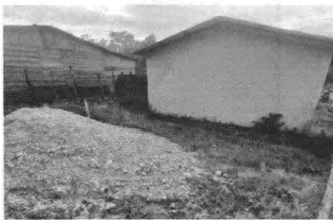
Foto 5: Espacio adecuado para los baños.
