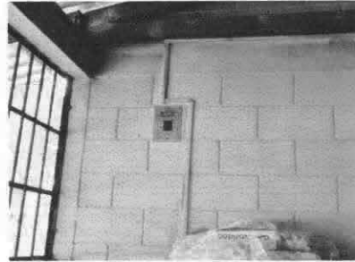
Foto2: Cambio de tablero de flipon.
