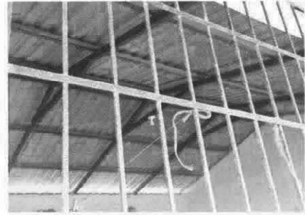
Foto 2: balcones sin pintura y oxidados.
