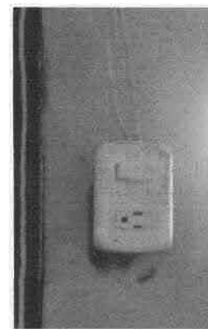
Foto 6: Cambio de cableado de tomacorrientes.
