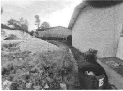
Foto1: Antes de la realización de los baños.
