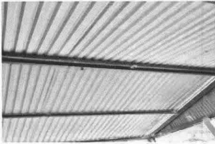
Foto 3: cambio de palfonerías
