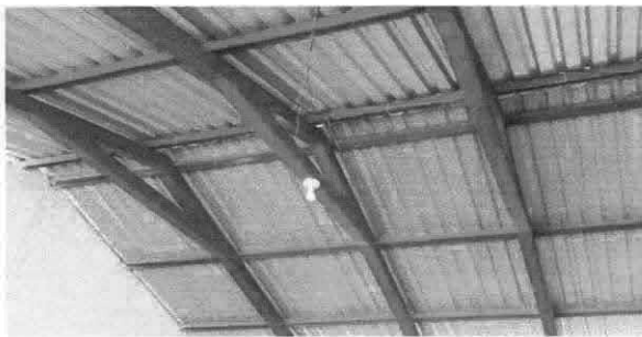
Foto 5: Cambio de focos ahorradores
