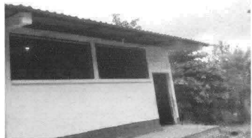
Foto 6: Pintar para mejor vista en las aulas.
