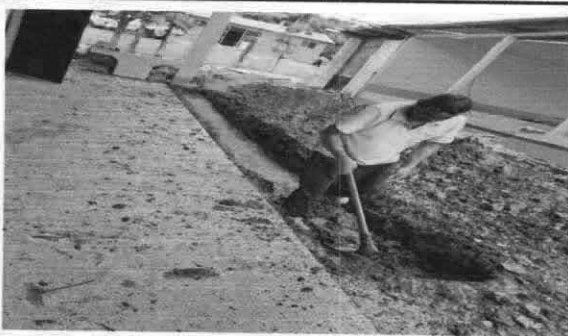
Foto 5: Instalación de tubería principal de PVC
