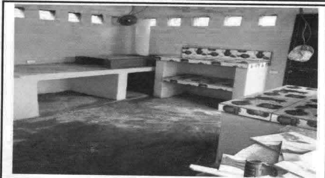
Foto 14: Mantenimiento de estufa rural
