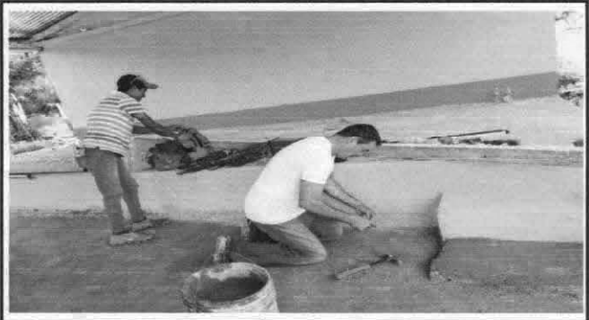
Foto 8: Sustitución de piso de torta de concreto
