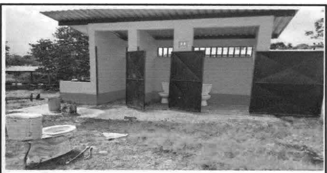
Foto 12: Instalación de inodoro
