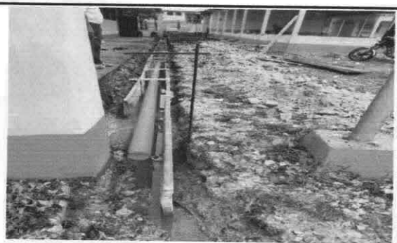
Foto 6: Instalación de tubería principal de PVC
