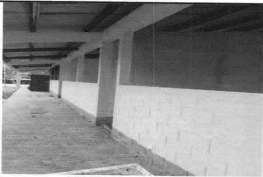
Foto 3: Pintura de muros exteriores e interiores
