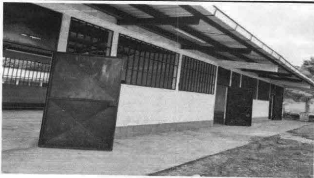
Foto 15: Mantenimiento de estructura (lijado, cepillado y pintado)
