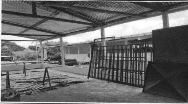
Foto1: Mantenimiento de Balones de metal
