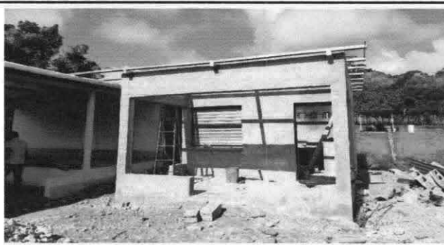
Foto 9: Instalación de lámina troquelada aluzinc calibre 26
