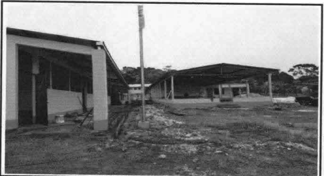
Foto 4: Pintura de muros exteriores e interiores
