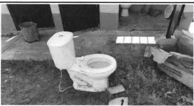
Foto 11: Instalación de inodoro
