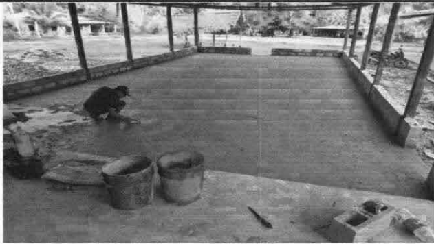
Foto 7: Sustitución de piso de torta de concreto
