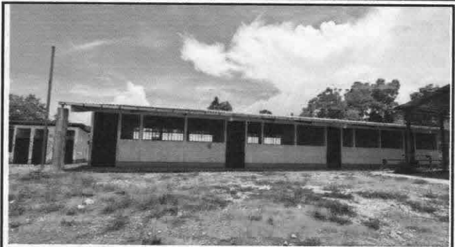
Foto 2: Pintura de muros exteriores e interiores
