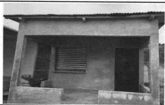
Foto 4: Instalación de lámina troquelada aluzinc calibre 26
