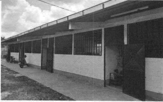
Foto 1: Mantenimiento de Balones de metal
