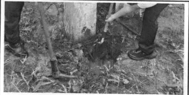
Foto 9: Sustitución de tubería PVC línea principal aguas negras
