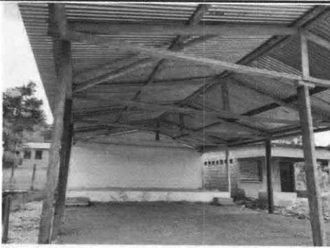
Foto 3: Sustitución de piso de torta de concreto
