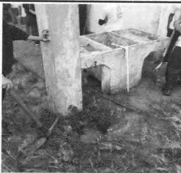
Foto 5: Instalación de tubería principal de PVC
