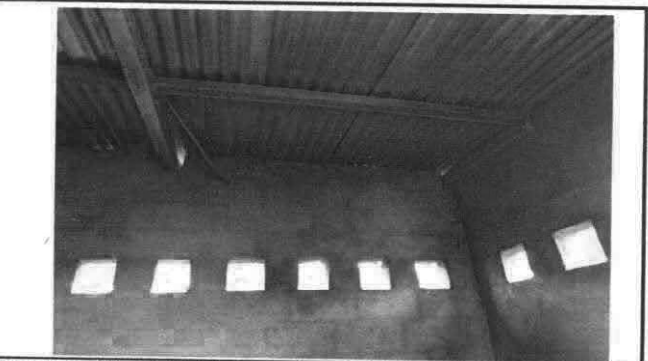
Foto 10: Sustitución de lámina por lámina troquelada aluzinc calibre 26
