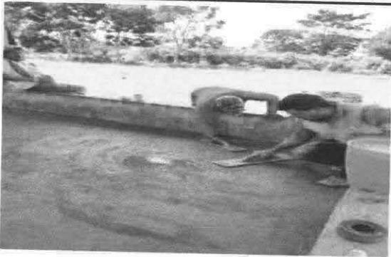
Foto 1: REPARACIÓN DE PISO DE TORTA DE CONCRETO
