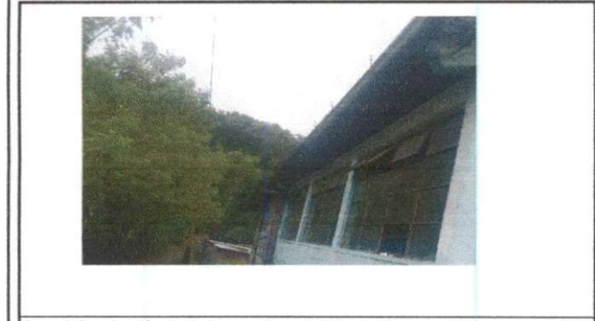
Foto 3: Sustitución de balcones de metal
