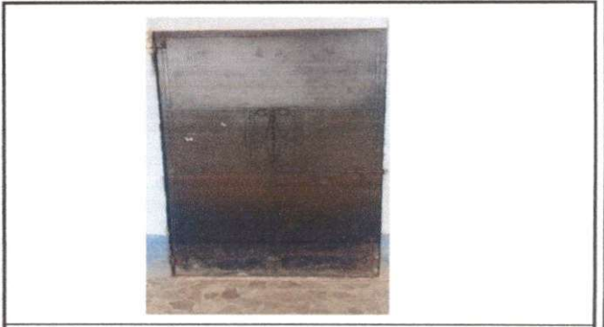
Foto 2: Sustitución de puertas
