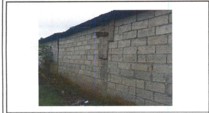
Foto1: Pintura en muros exteriores e interiores
