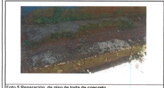
Foto 5: Reparación de piso de torta de concreto
