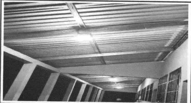
Foto 4: REPARACION DE CABLEADO ELECTRICO
