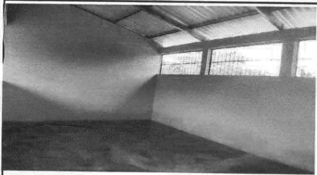
Foto 3: SUSTITUCION DE PISO DE CEMENTO LIQUIDO
