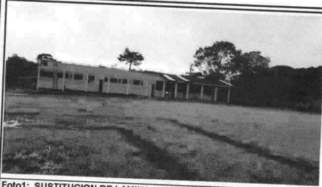
Foto 1: SUSTITUCION DE LAMINA POR LAMINA TROQUELADA
