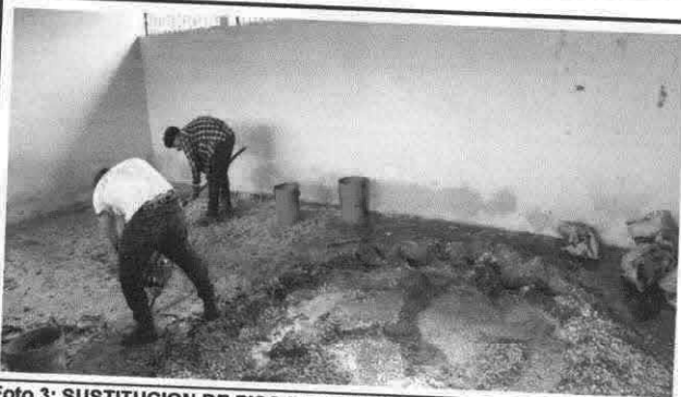
Foto 3: SUSTITUCION DE PISO DE CEMENTO LIQUIDO
