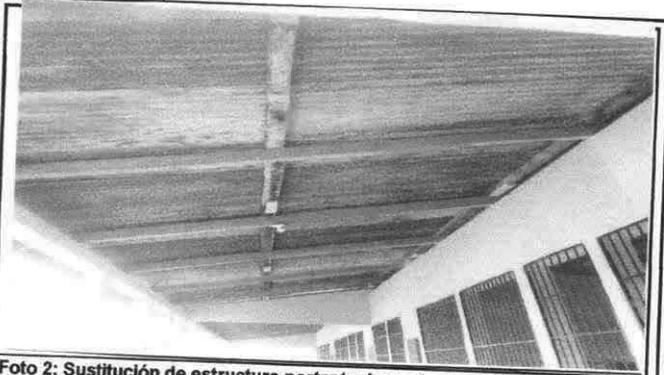
Foto 2: Sustitución de estructura portante de madera por metal
