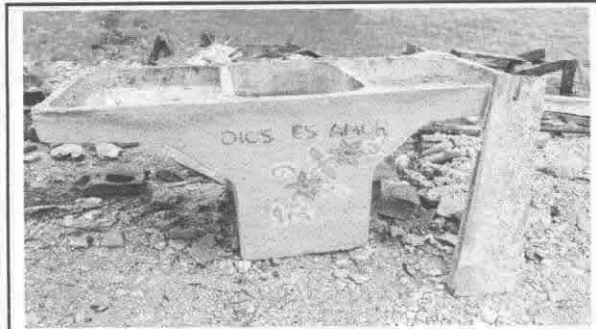
Sustitución de pila de concreto de 2 lavaderos
