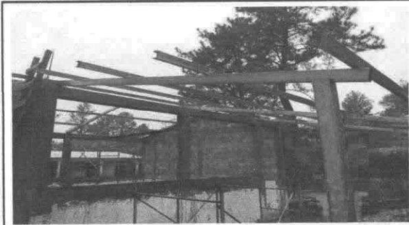
Sustitución de lámina por lamina troquelada aluzinc C2 y sustitución de capotes de lámina troquelada
