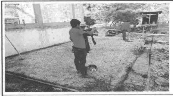
Sustitución de piso de torta de concreto
