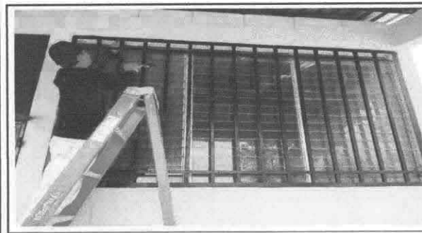
Mantenimiento de balcones
