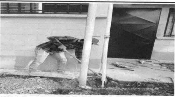
Sustitución de tubería principal
