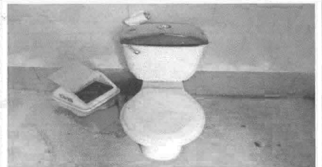
Foto2:sustitución de inodoros
