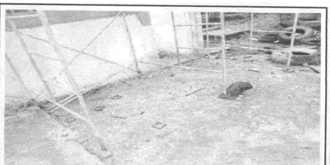
Foto 6: Sustitución de piso de torta de concreto
