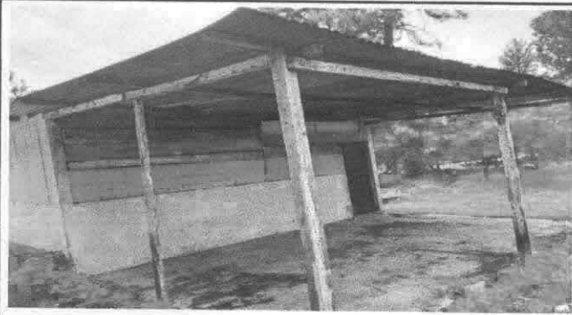
Foto1: Sustitución de láminas, por lamina troquelada aluzinc C2 y sustitución de capotes de laminas troqueladas
