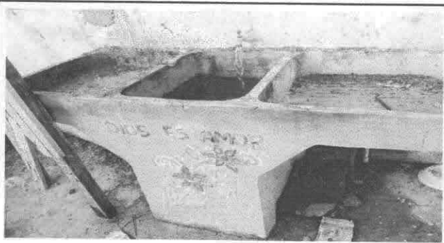
Foto 3: Sustitución de pila de concreto de 2 lavaderos
