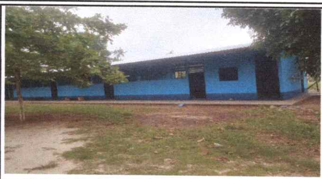
Foto 2: Terminación de techo
