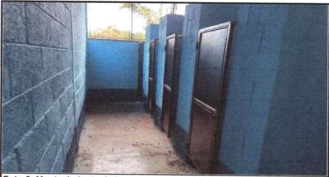
Foto 5: Mantenimiento de inodoros lavables terminado
