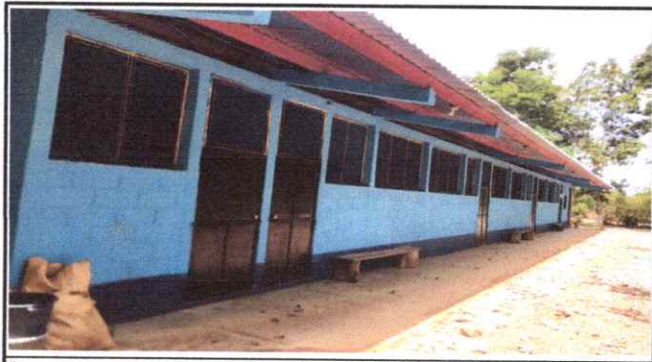
Foto 3: Pintura en muros interior y exterior
