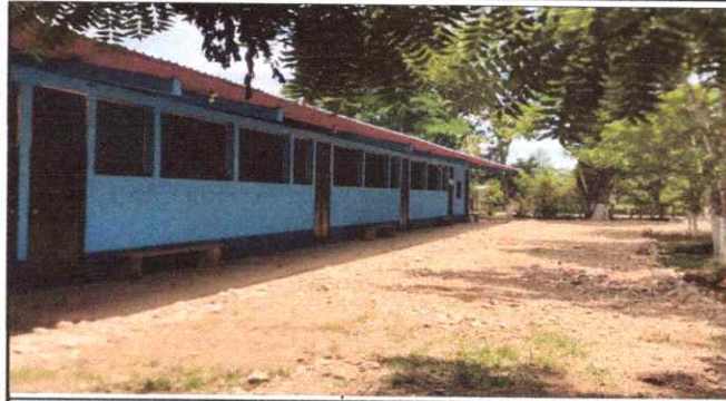
Foto 1: TERMINACION PUESTA A LÁMINA
