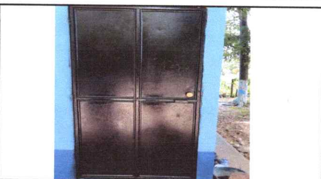
Foto 4: Mantenimiento a puerta de metal terminado
