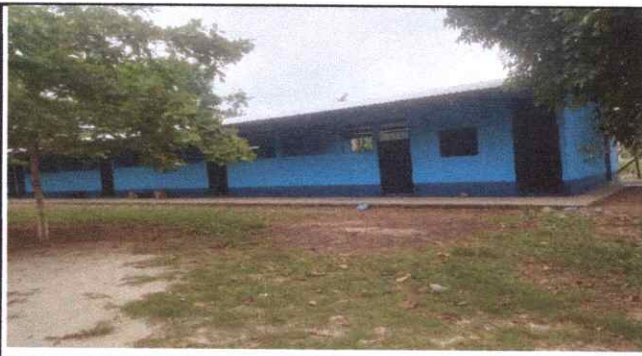
Foto 3: Pintura en muros interior y exterior
