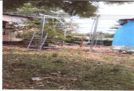
Foto 2: Instalación de techo
