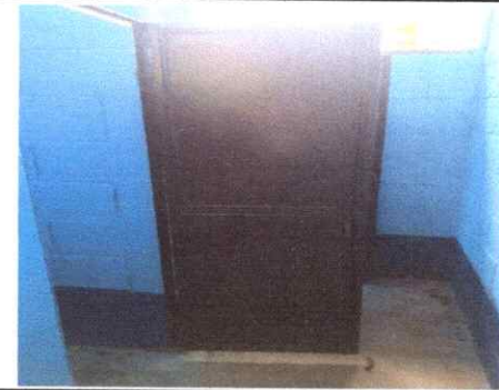
Foto 4: Mantenimiento a puerta de metal
