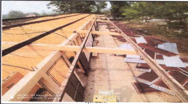
Foto 1: CUBIERTA DE LÁMINA
