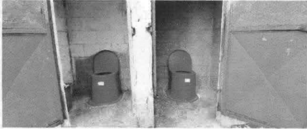
Foto1: Sustitución de inodoro
