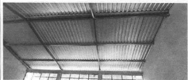
Foto 4: Instalación de lámina troquelada
