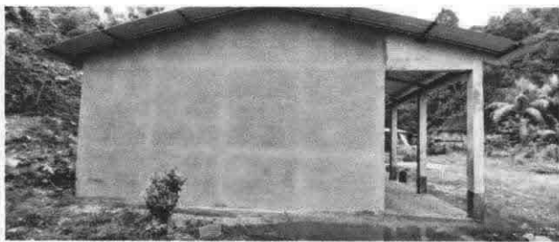
Foto 3: Repello en muro
