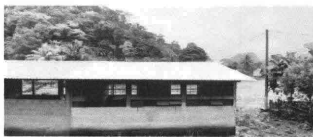
Foto 5: Instalación de lámina troquelada
