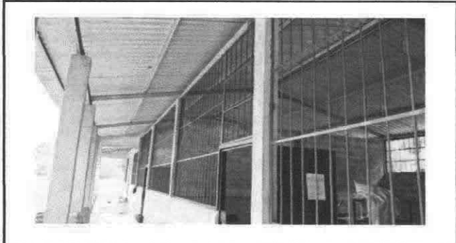
Foto1: Sustitución de balcones de metal
