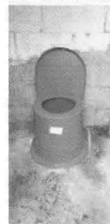
Foto 6: Sustitución de inodoro
