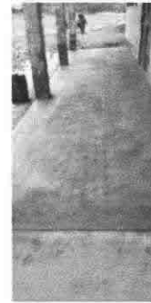
Foto 2: Sustitución de piso de torta de concreto
