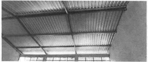
Foto 4: Instalación de estructura portante de metal
