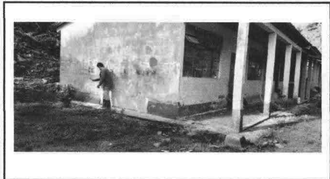
Foto 3: Repello en muro
