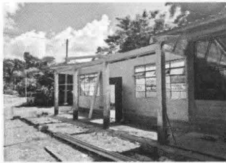
Foto 3: Instalación de estructura portante de metal
