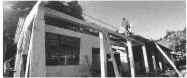
Foto 2: Sustitución de capote de lámina para lámina troquelada
