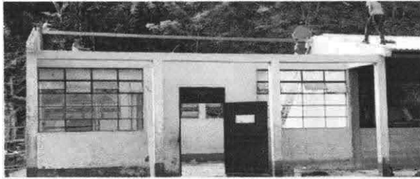
Foto 1: Instalación de lámina troquelada Aluzinc
