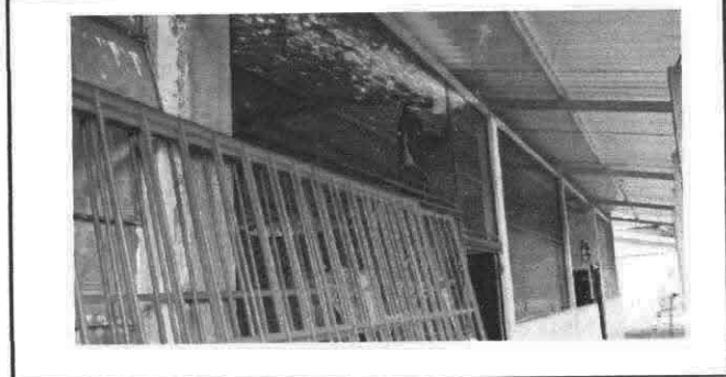
Foto 2: Sustitución de balcones de metal
