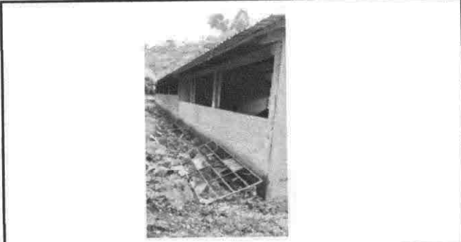
Foto1: Sustitución de balcones de metal
