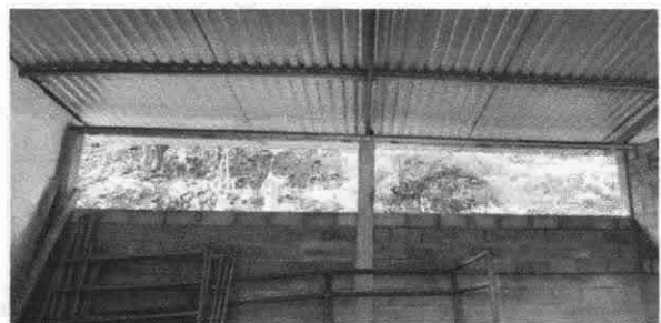
Foto 6: Sustitución de balcones de metal
