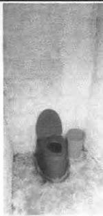
Foto 5: SUSTITUCION DE INODORO
