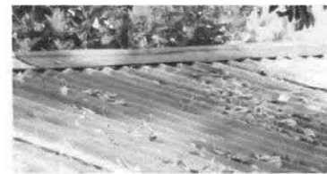
Foto 6: SUSTITUCIÓN DE CAPOTE DE LÁMINA PARA LÁMINA TROQUELADA
