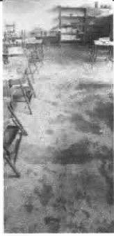
Foto 1: SUSTITUCIÓN DE PISO DE TORTA DE CONCRETO
