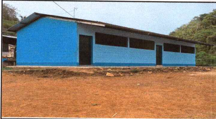
Foto1: Pintura en muros exteriores e interiores
