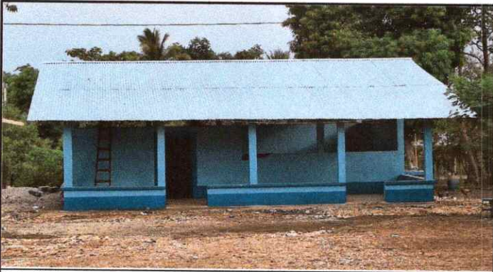
Foto 3: Repello en muros.
