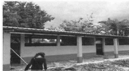
Foto 6: Pintura en muros exteriores e interiores
