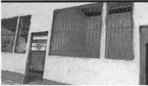
Foto 3: Sustrucción de ventanas de madera por metal
