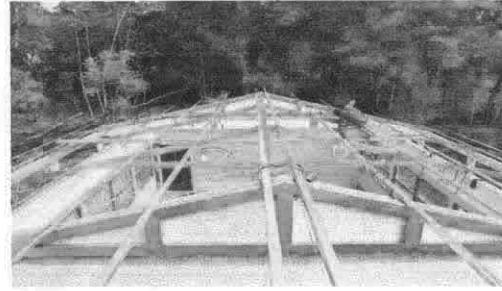
Foto 2: Sustrucción de estructura de soporte de madera por metal
