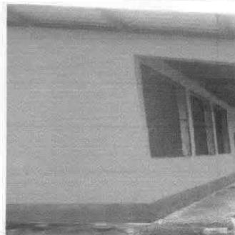
Foto 6: Pintura en muros exteriores e interiores
