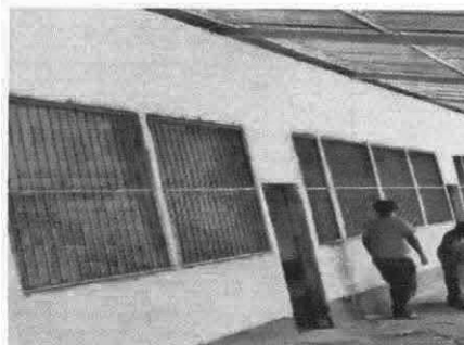
Foto 4: Fabricación e instalación de Balcones de hierro en ventana
