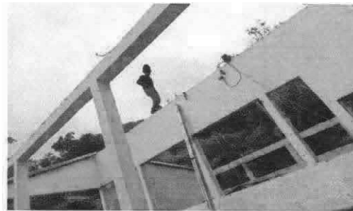
Foto 2: Sustitución de estructura de soporte de madera por metal
