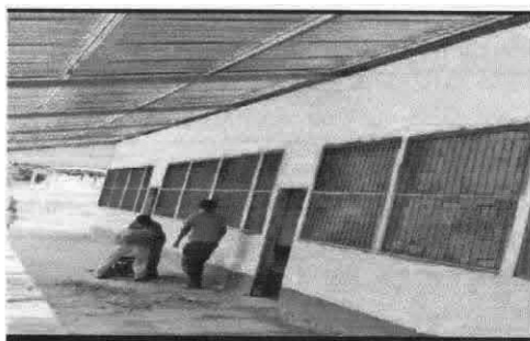
Foto 3: Sustitución de ventanas de madera por metal
