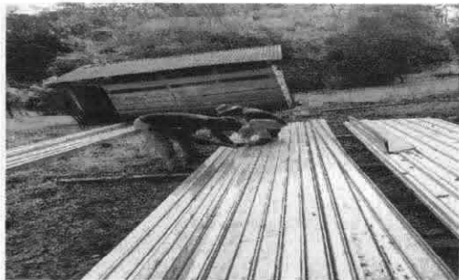
Foto1: Sustitución de lamina
