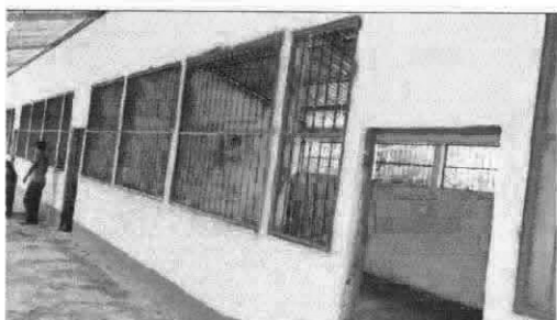
Foto 5: Sustitución de puerta
