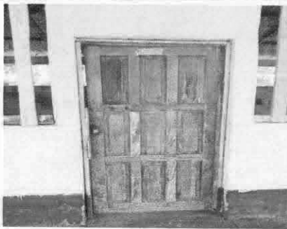
Foto 5: Sustitución de puerta
