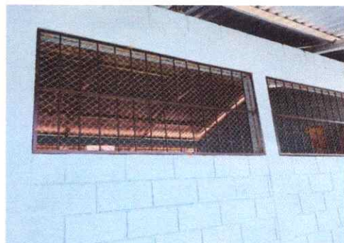
Foto 4: COLOCACIÓN DE BALCONES
