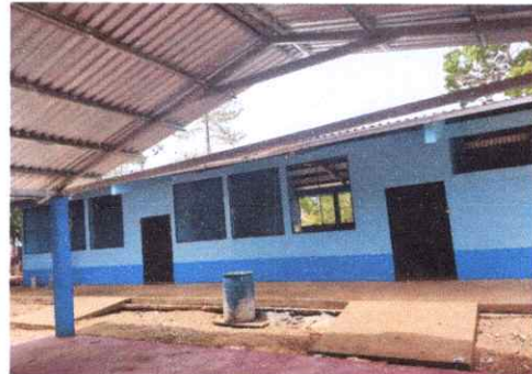
Foto 2: PINTURA PARA INTERIOR Y EXTERIOR DE AULAS
