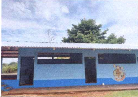
Foto 1: CAMBIO DE TECHO Y LÁMINA
