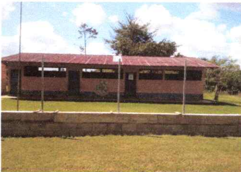
Foto 3: CAMBIO DE LÁMINAS Y COSTANERAS
