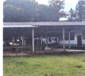
Foto 6: CAMBIO DE LÁMINAS, COSTANERAS Y PISO PARA ESCENARIO
