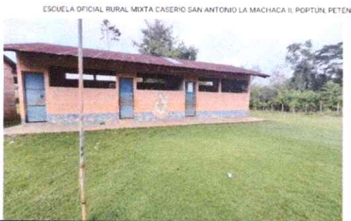
Foto 5: CAMBIO DE PUERTAS
