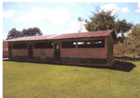
Foto 4: PINTURA PARA PAREDES Y BALCONES
