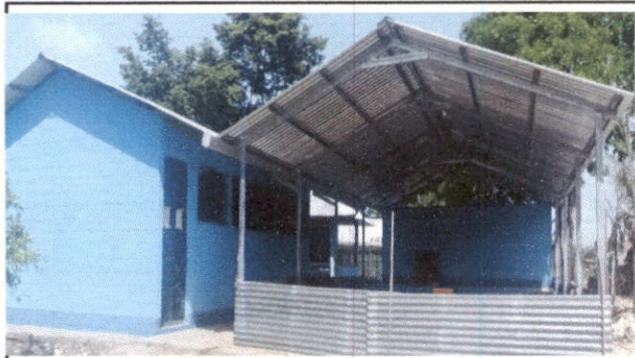
Foto1: Pintura en muros exteriores e interiores
