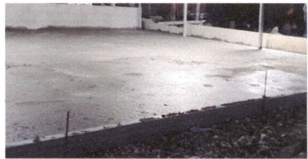
Foto 4: Sustitución de piso torta de concreto
