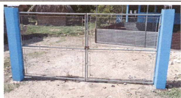
Foto 6: Sustitución de porton y muro de concreto
