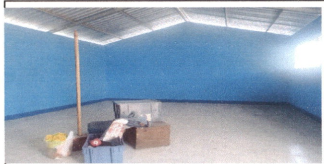
Foto 2: Sustitución de piso cerámico
