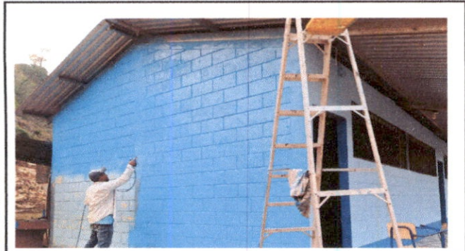
Foto1: Pintura en muros exteriores e interiores
