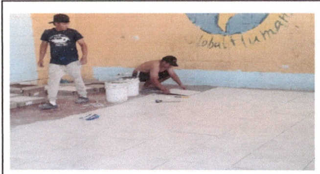
Foto 2: Sustitución de piso cerámico
