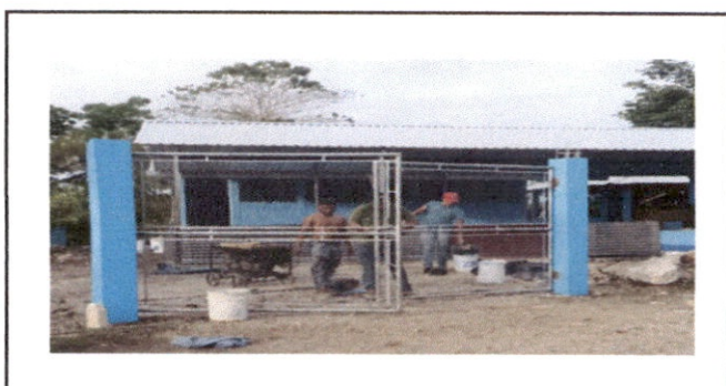
Foto 6: Sustitucion de muro concreto.
