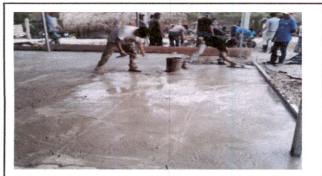
Foto 3: colocacion de piso de concreto
