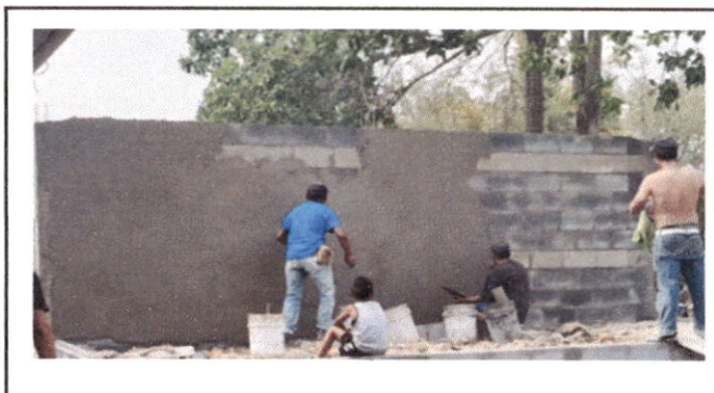
Foto 4: Repello de muro
