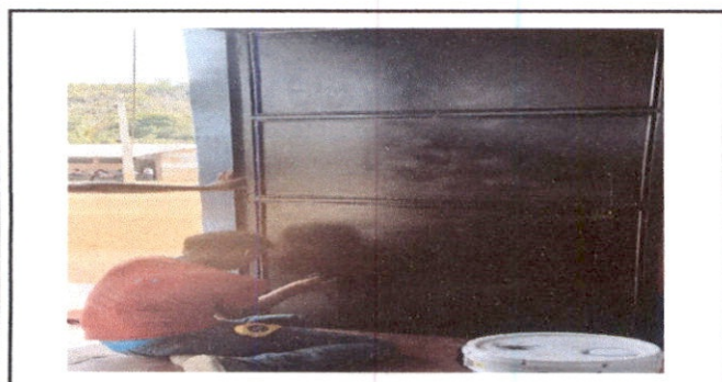
Foto 5: Mantenimiento a estructura ( lijado, cambiado de tubo, cepillado, sujeción, aplicación de pintura)
