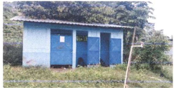
fabricación e instalación de puertas de metal
