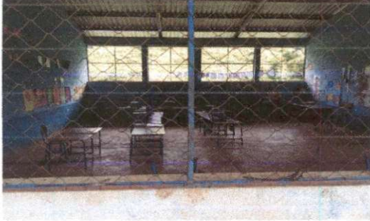
Sustitucion de balcones de metal
