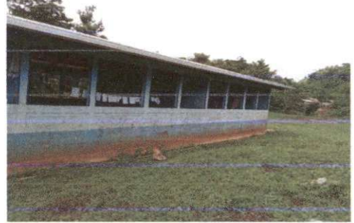
Pintura en muros exteriores e interiores
