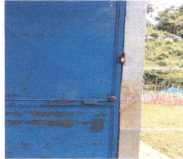
sustitución de chapas
