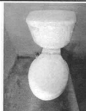
Foto 6: Sustitución de inodoro e instalación
