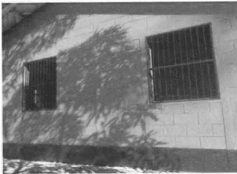
Foto 9: Fabricación e instalación de balcones de hierro
