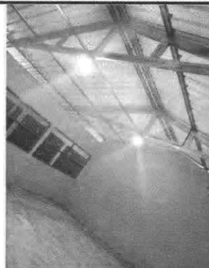
Foto 2: 1. Sustitución de estructura de soporte madera por metal, 2. Sustitución de elementos de fijación, 3. Instalación de estructura portante de metal
