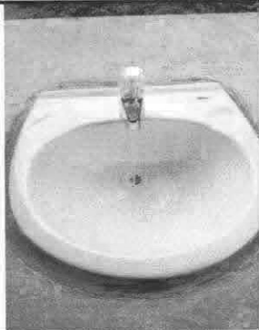
Foto 11: Sustitución de lavamanos
