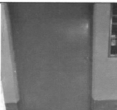
Foto 4: Sustitución de puerta
