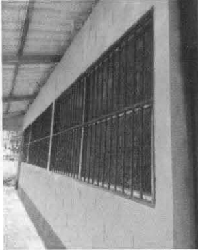
Foto 7: Pintura de muros exteriores e interiores
