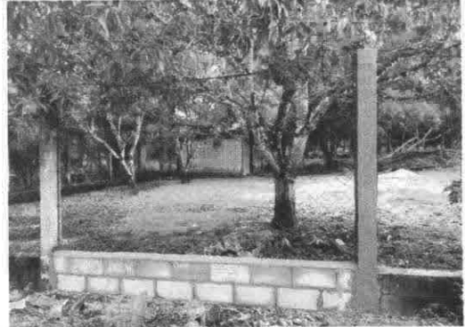
Foto 8: Reparación de muro perimetral de block
