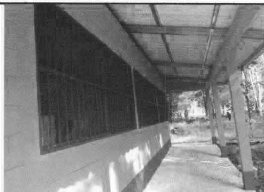
Foto 3: Sustitución de balcones de metal
