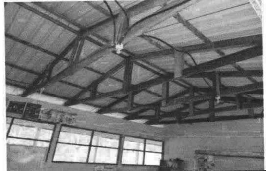
Foto 2: 1. Sustitución de estructura de soporte madera por metal, 2.Sustitución de elementos de fijación, 3.Instalación de estructura portante de metal
