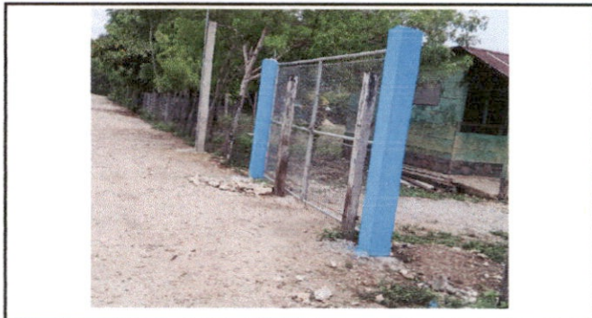
Foto 2: Reparación del portón principal
