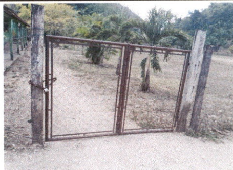
Foto 2: Reparación del portón principal
