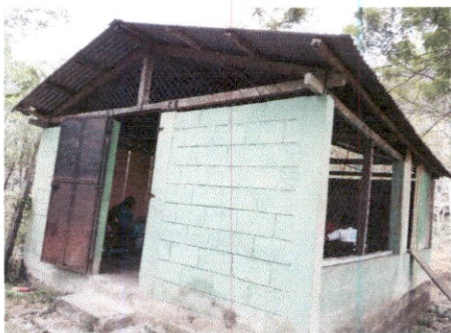
Foto 3: Reparación de techo, sustitución de estructura, techo y puerta.
