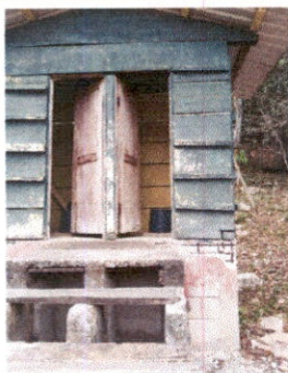
Foto 1: Reparación de Baños
