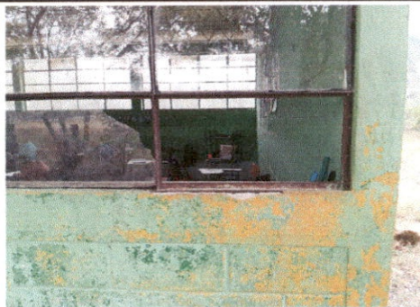
Foto 4: Reparación de balcones
