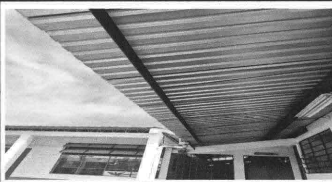
Foto 2: MANTENIMIENTO DE ESTRUCTURA PORTANTE DE MADERA POR METAL
