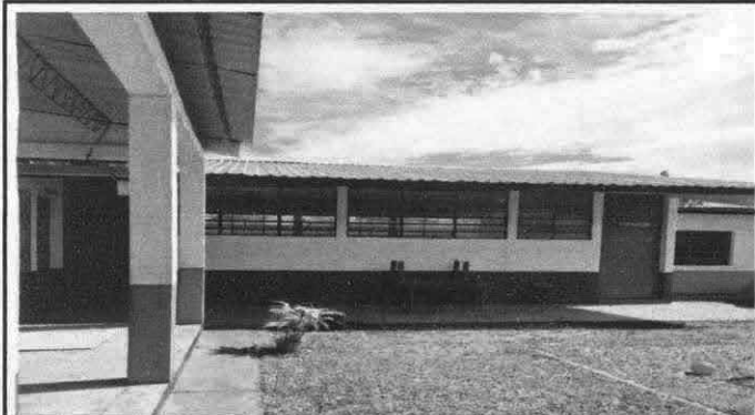
Foto1: SUSTITUCION DE LAMINA POR LAMINA TROQUELADA
