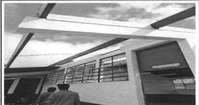
Foto 2: MANTENIMIENTO DE ESTRUCTURA PORTANTE DE MADERA POR METAL
