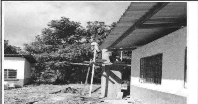
Foto 4: SUSTITUCION DE DEPOSITO DE AGUA DE 1700 lts.
