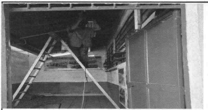
Foto 5: REPARACION DE FOCOS AHORRADORES
