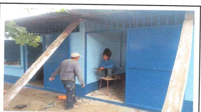
SUSTITUCIÓN DE PUERTAS EN MODULO DE COCINA
