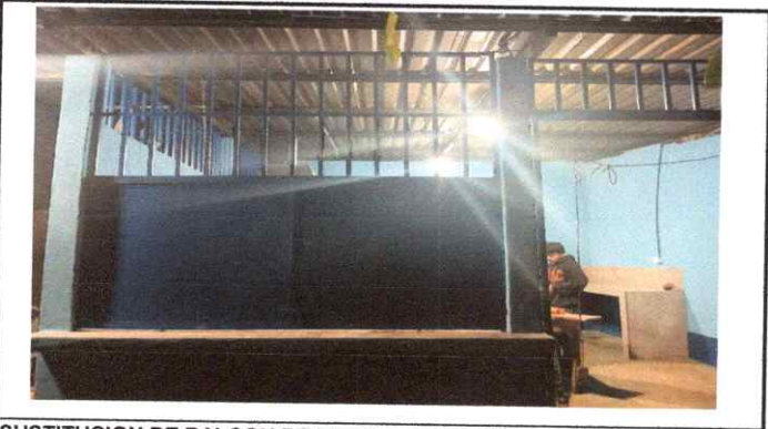
SUSTITUCION DE BALCON DE METAL EN VENTANA
