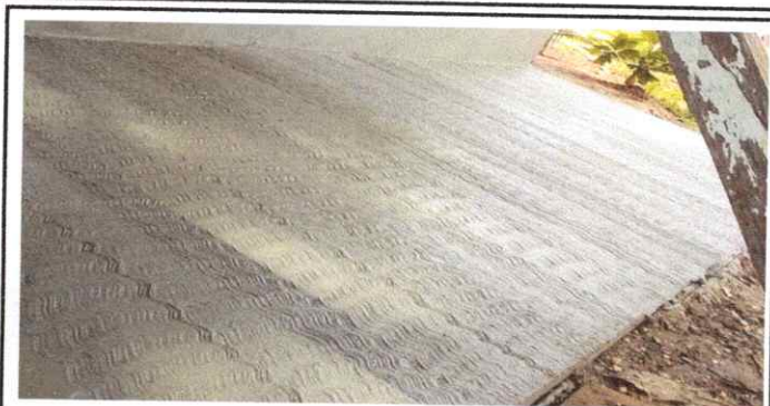
SUSTITUCIÓN DE TORTA DE CONCRETO
