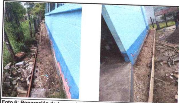
Foto 6: Reparación de banqueta de concreto (Durante)
