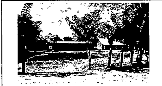
Foto 1: Cerco o muro perimetral
