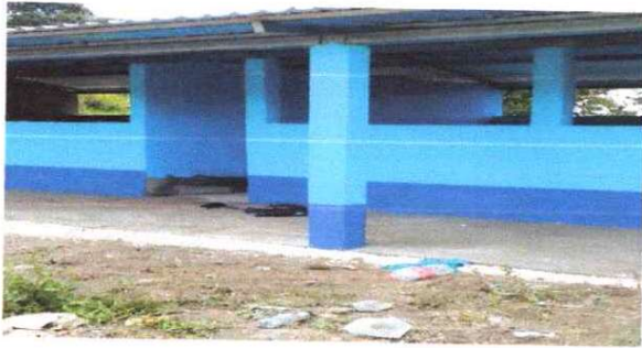
Foto1: PINTURA DE MUROS EXTERIOR E INTERIOR
