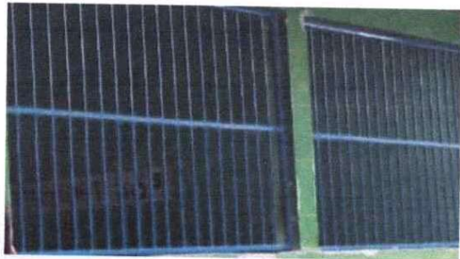
Foto 3: SUSTITUCION DE BALCONES DE METAL
