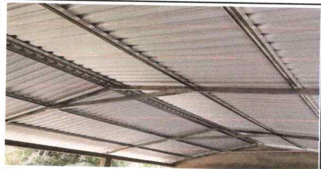
Foto 6: SUSTITUCION DE ESTRUCTURA SOPORTE DE MADERA POR METAL
