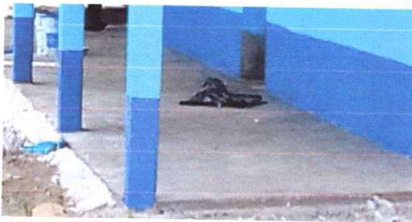
Foto 5: REPARACION DE PISO TORTA DE CONCRETO
