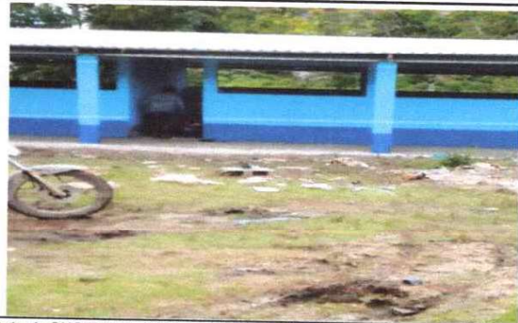
Foto 4: SUSTITUCION DE LAMINA, POR LAMINA TROQUELADA CALIBRE 26
