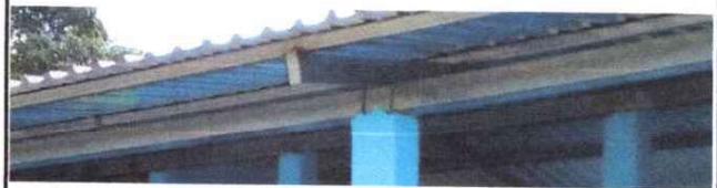
Foto 4: SUSTITUCION DE LAMINA, POR LAMINA TROQUELADA CALIBRE 26
