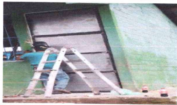
Foto 2: SUSTITUCION DE PUERTAS
