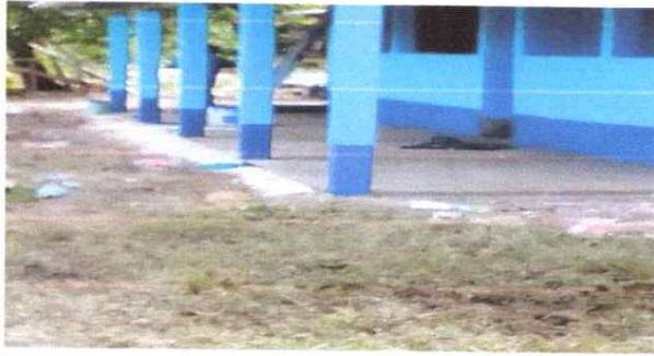
Foto 1: PINTURA DE MUROS EXTERIOR E INTERIOR
