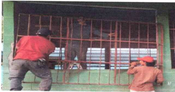
Foto 3: SUSTITUCION DE BALCONES DE METAL
