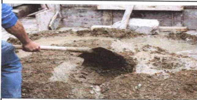
Foto 5: REPARACION DE PISO TORTA DE CONCRETO
