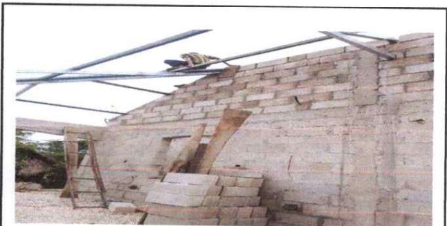
Foto 6: SUSTITUCION DE ESTRUCTURA SOPORTE DE MADERA POR METAL
