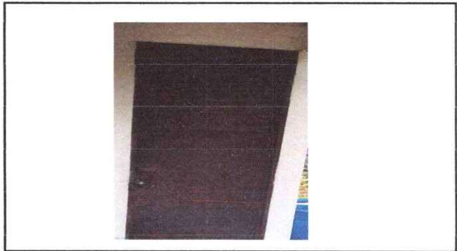
Foto 2: Sustitución de puertas
