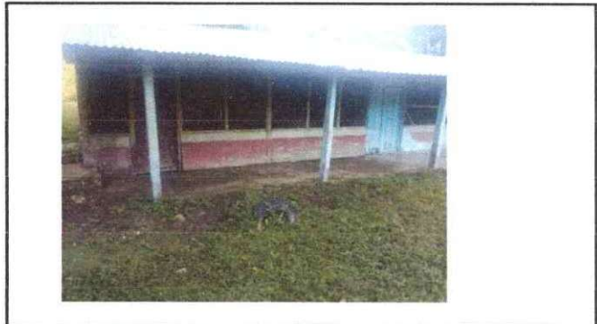
Foto 4: Sustitución de lámina, por lámina troquelada aluzinc calibre 26 Sustitución de elementos de fijación en cubierta de lamina
