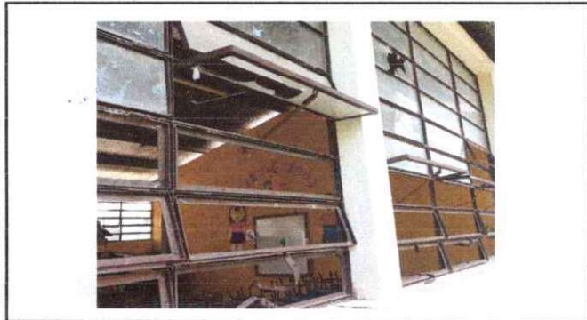
Foto 3: Sustitución de balcones de metal
