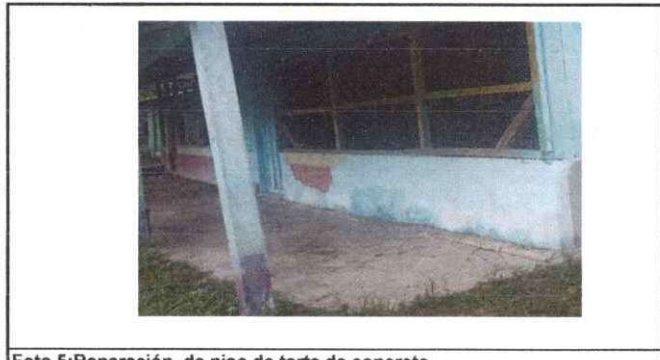
Foto 5: Reparación de piso de torta de concreto
