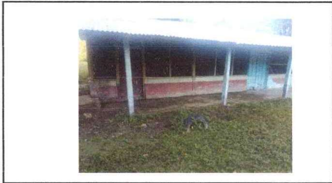
Foto1: Pintura en muros exteriores e interiores
