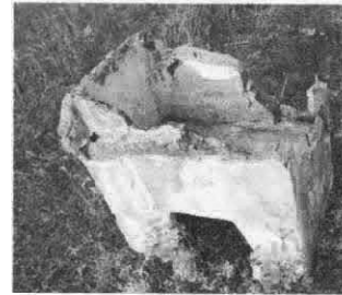
Foto 10: sustitución de pila de cemento de dos lavaderos.
