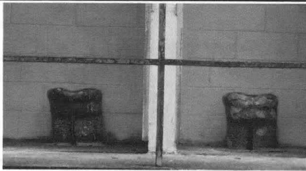
Foto 9: Sustitución de inodoro.
