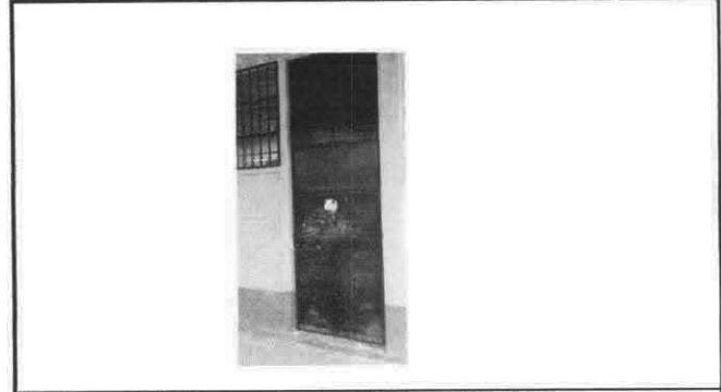
Foto 4: Mantenimiento a estructura (lijado, cambio de tubo, cepillado, sujeciones, aplicación de pintura).
