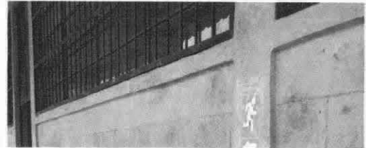
Foto 8: Pintura en muros exteriores e interiores.
