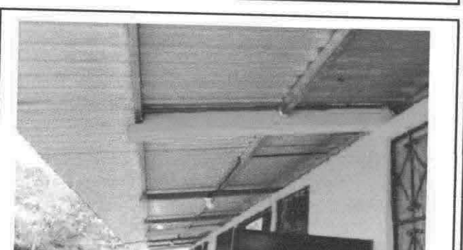
Foto 10: Sustitución de elementos de fijación en cubierta de lamina
