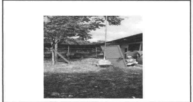
sustitución de chapas
