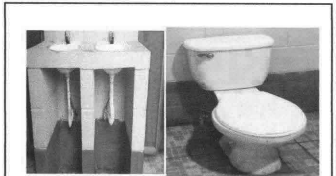
sustitución de accesorios inodoro, sustitución de accesorios lavamanos
