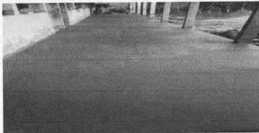
Foto 5: Reparación de piso de torta de concreto
