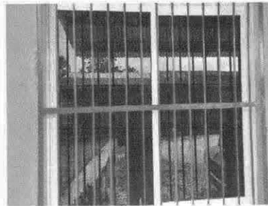
Foto 6: Sustitución de ventanas de madera por metal mas vidrio
