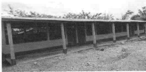
Foto 1: Pintura en muros exteriores e interiores
