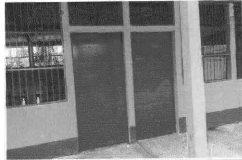
Foto 2: Sustitución de puertas
