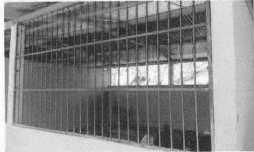
Foto 4: Fabricación e instalación de balcones de hierro
