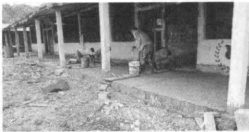
Foto 5: Reparación de piso de torta de concreto
