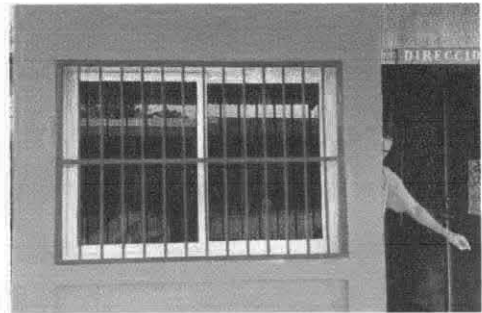
Foto 6: Sustitución de ventanas de madera por metal mas vidrio
