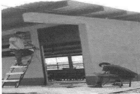
Foto 1: Pintura en muros exteriores e interiores
