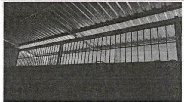
remozamiento vigas y costaneras
