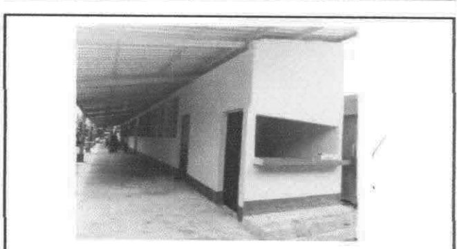
Foto 6: Sustitución de piso
