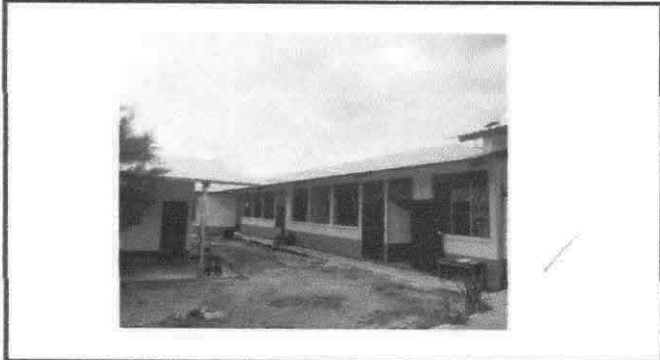
Foto1: Cambio de lámina y estructura dañadas
