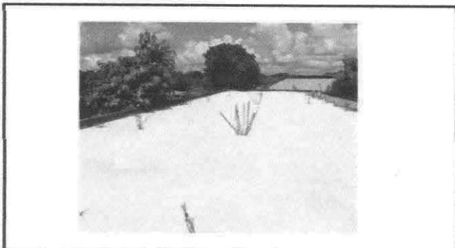
Foto 3: Terraza con impermeabilizante
