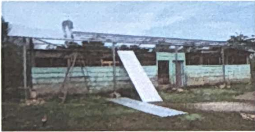
Foto 7: INSTALACION DE LAMINA
