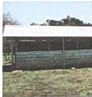
Foto 10: INSTALACION DE LAMINA
