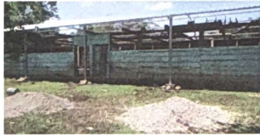
Foto 8: INSTALACION DE LAMINA
