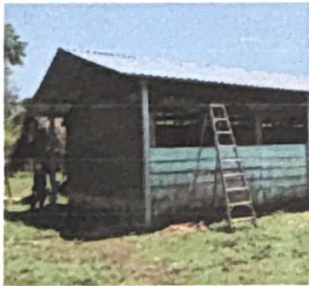
Foto 9: INSTALACION DE LAMINA
