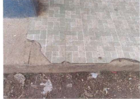
Foto 2: Sustitución de piso Ceramico antideslizante
