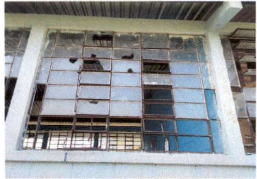
Foto 4: Sustitución de balcones de metal
