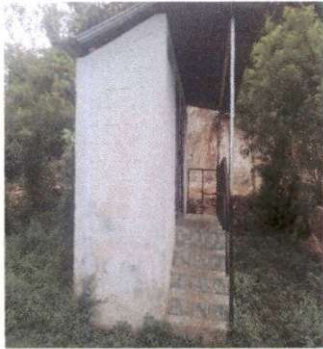
Foto 3: Pintura en muros exteriores e interiores
