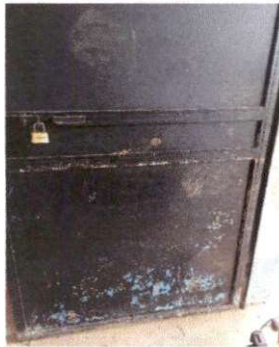
Foto 5: Mantenimiento lijado y pintura a puertas
