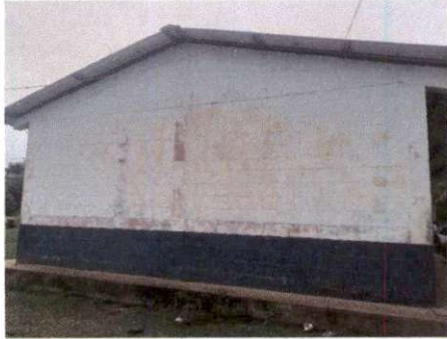
Foto 1: Pintura en muros exteriores e interiores
