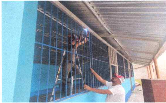
Foto 3: Sustitución de balcones de metal
