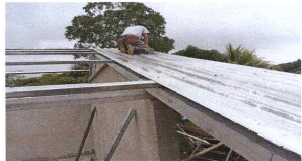
Foto 4: Sustitución de lámina, por lámina troquelada aluzinc calibre 26 Sustitución de elementos de fijación en cubierta de lamina
