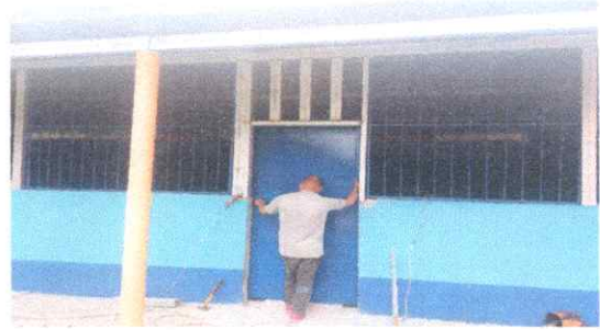
Foto 2: Sustitución de puertas
