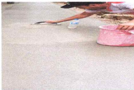
Foto 5: Reparación de piso de torta de concreto
