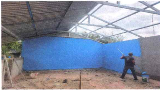
Foto1: Pintura en muros exteriores e interiores
