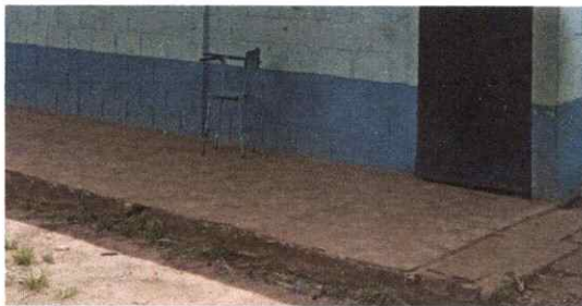
Foto 5: Reparación de piso de torta de concreto
