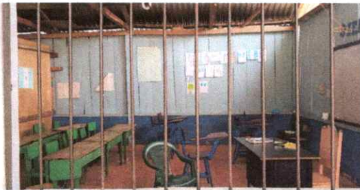
Foto 3: Sustitución de balcones de metal
