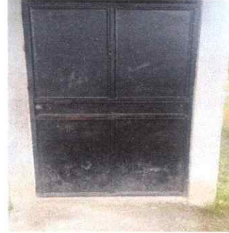
Foto 2: Sustitución de puertas
